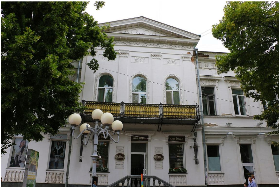
Рис. А.4. Жилий будинок по вул.Соборності 34 (м.Полтава), колишня Ремісничка управа
