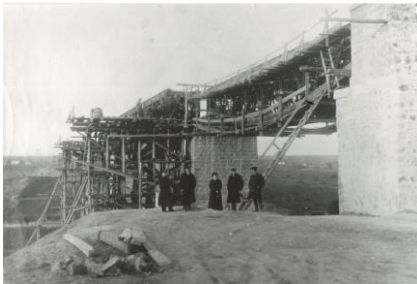
Рис. 15. Будівництво моста через Сулу 1901 р.
